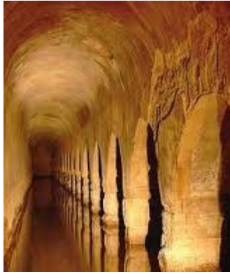
Cisterna del Foro. Dispone de dos naves abovedadas separadas por 21 pilares.
