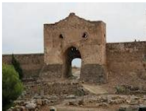
Estructuras arquitectónicas conservadas del Foro.Plaza de Armas. Castillo de Sagunto.
