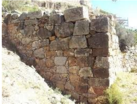
Muralla ibérica de Arse. Tres Pouets
