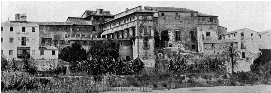
14. Lado este, hacia el río Serpis, del Palacio Ducal se aprecian volúmenes de la Sala de Coronas; antes de las intervenciones realizadas a finales del siglo XIX y comienzos del XX.
